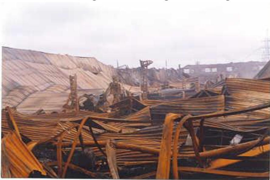
Ảnh 5: Dấu vết cong vênh biến dạng của hệ thống dàn mái
